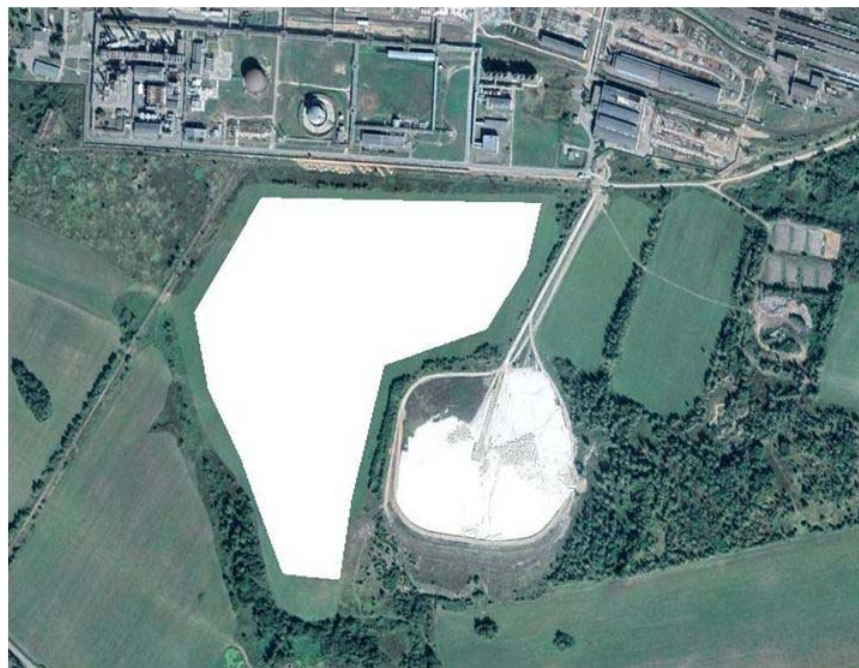
Рисунок 2.1 – Участок производства работ
